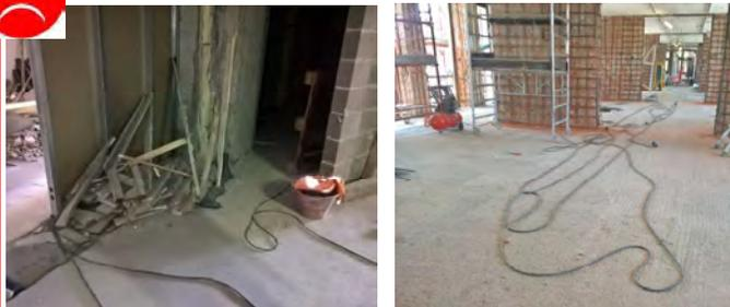
ESEMPIO NEGATIVO DI PROLUNGHE ELETTRICHE DEPOSITATE A TERRA CON GENERAZIONE DI PERICOLO DI INCIAMPO.
