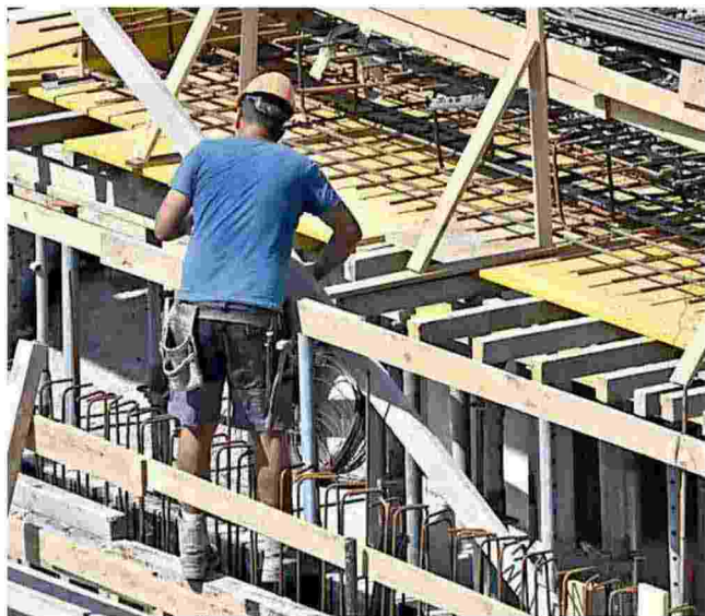
Un operaio edile al lavoro in un cantiere
