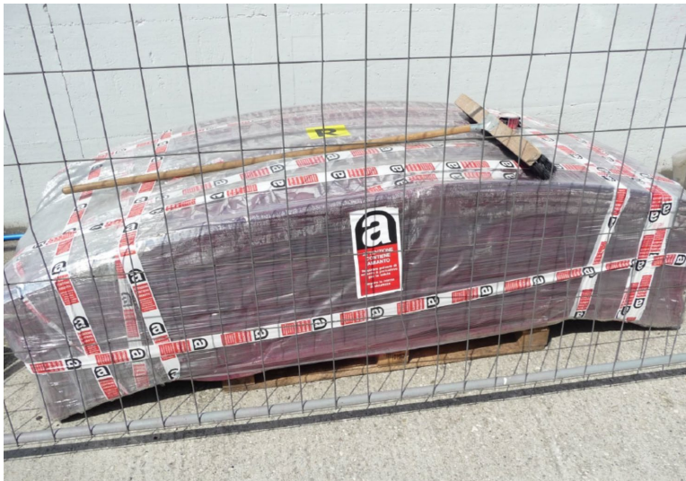
Rimozione e smaltimento
