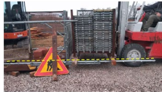
Fase 1: posizionamento del carico
