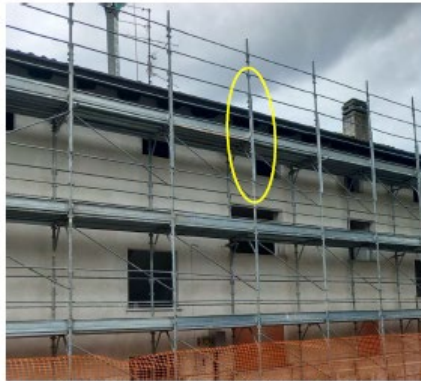
Elementi di rinforzo per i montanti all'ultimo impalcato del ponteggio
